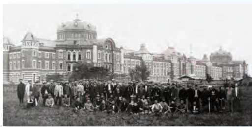
東京中央停車場 (現 東京駅) 1914年・東京
