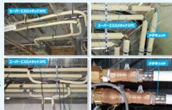
■スーパーエスロメタックスFCの配管 ●曲げ配管が自由に行えます。省スペースの施工もスムーズです。 ■メタキョットの接続部 ●継手部の強度が向上します。
