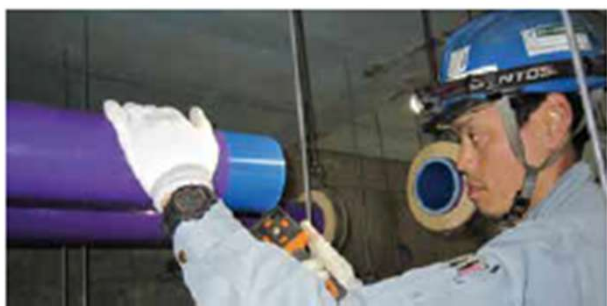
④融着面の切削（ハンスクレーパー）
