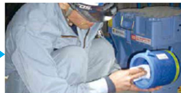
⑥融着面の清掃（継手側）
