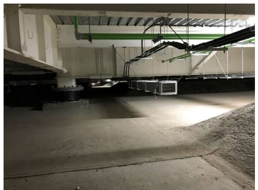
免震ピット内
