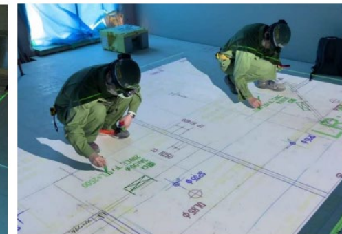
写真3 墨出し作業状況
