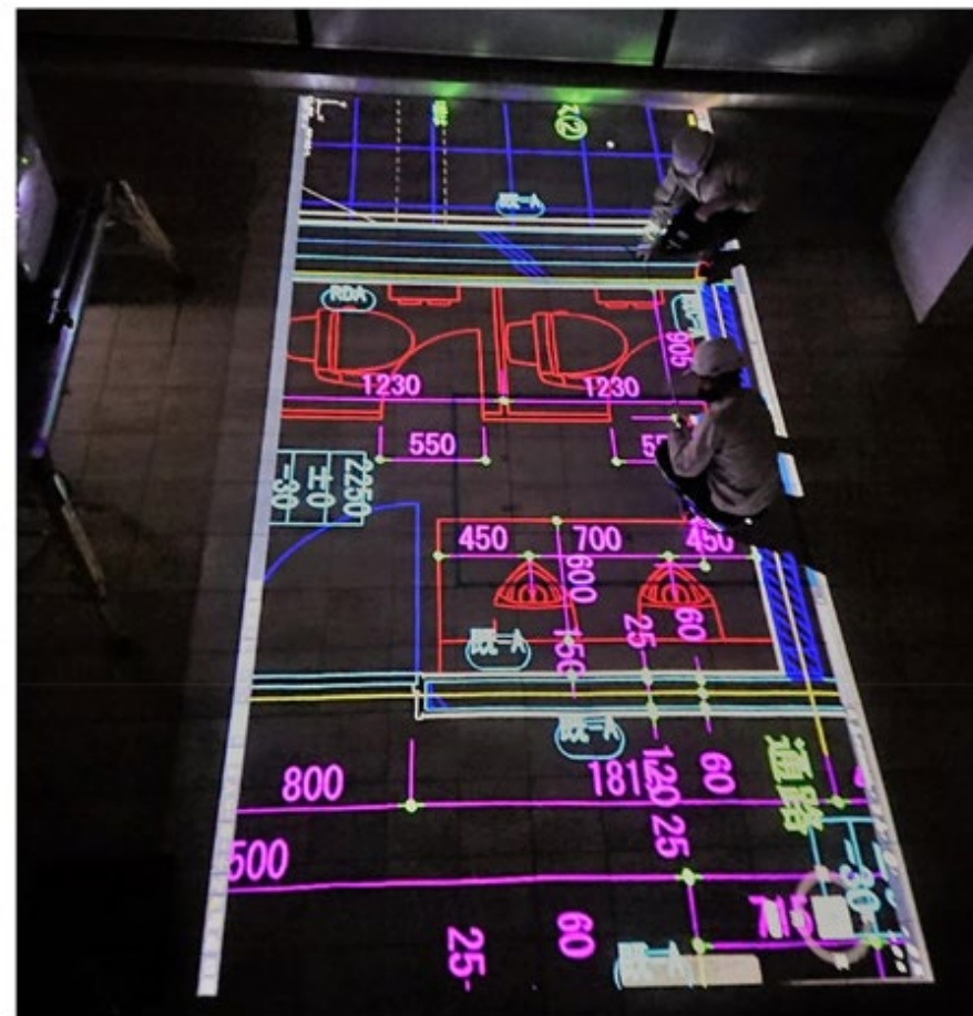
写真1 プロジェクションマッピングによる施工図面の投影状況
