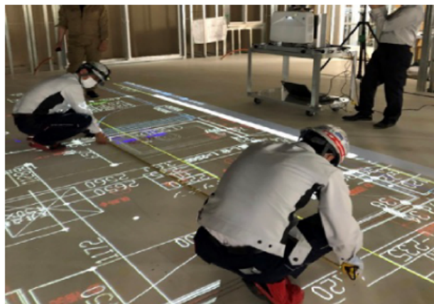
墨出し作業状況
