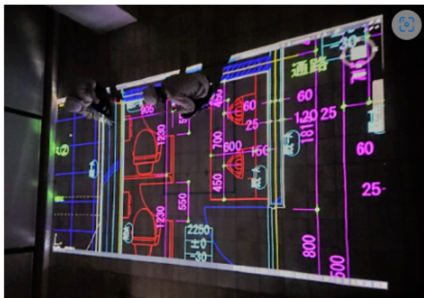
墨出し投影状況
