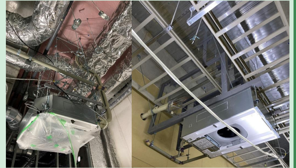
▲耐震振れ止め取付
