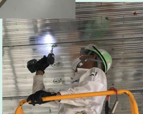
▲ アンカー打設
