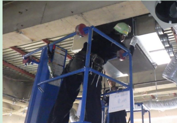
▲機器吊り込み
