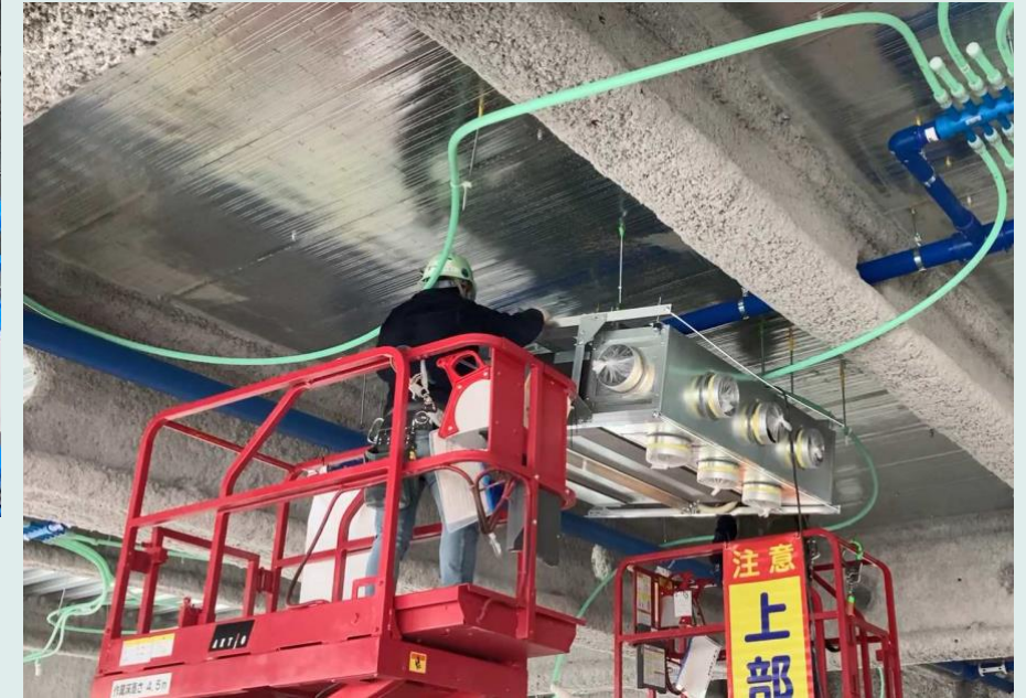
▲ ユニット吊り込み
