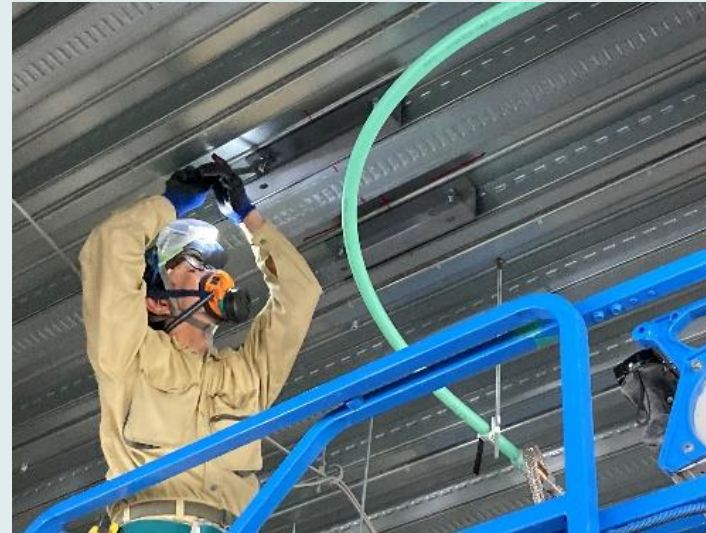
▲ アンカー打設
