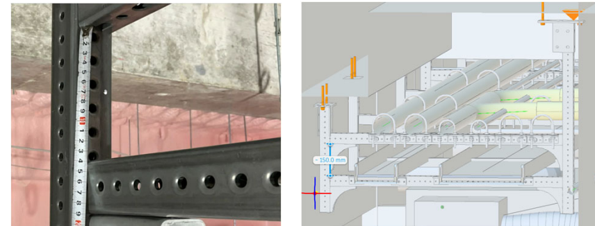
現場で計測しBIM360で確認
