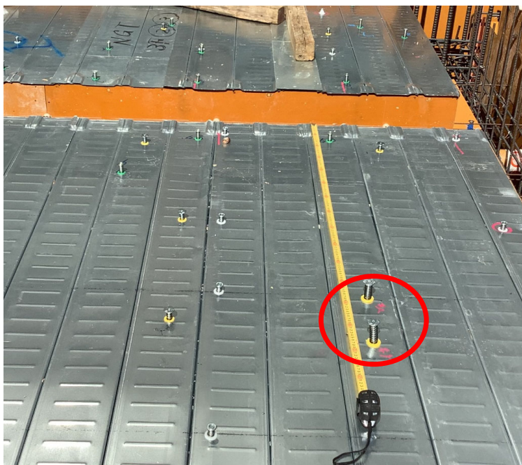
施工済みインサート
