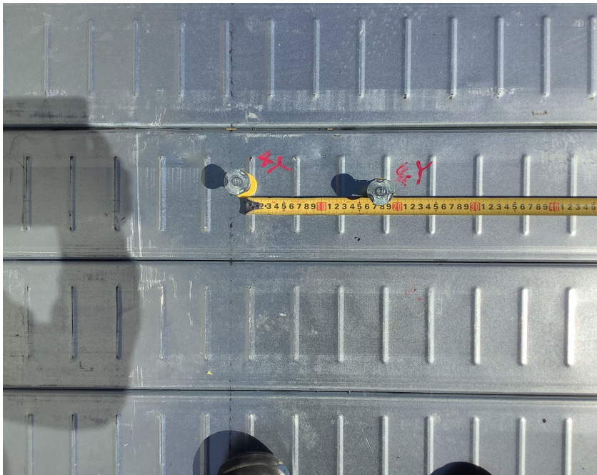
インサート取付け完了
