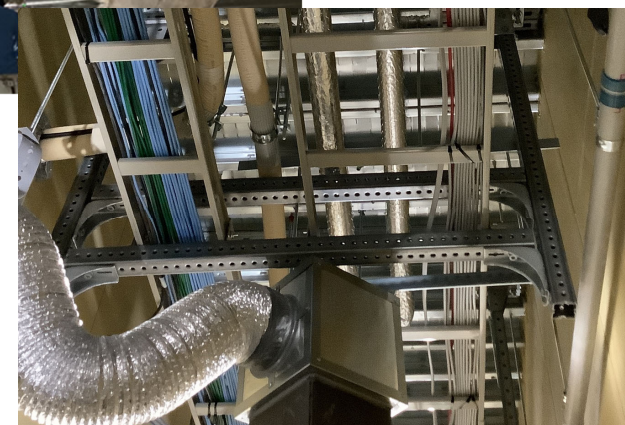
共通架台・ラック・配管 施工後
