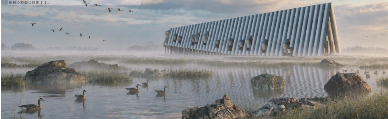
屋根：屋根の形状は風の通り道を作る
