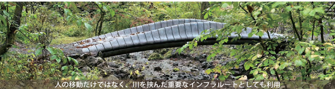
人の移動だけではなく、川を挟んだ重要なインフラードとしても利用
