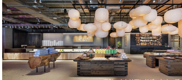
びわ湖材の仕切りや伝統的な京提灯を配置した物販スペース。左官壁や床仕上は信楽のさび石を混ぜ研ぎ出し仕上とした。
