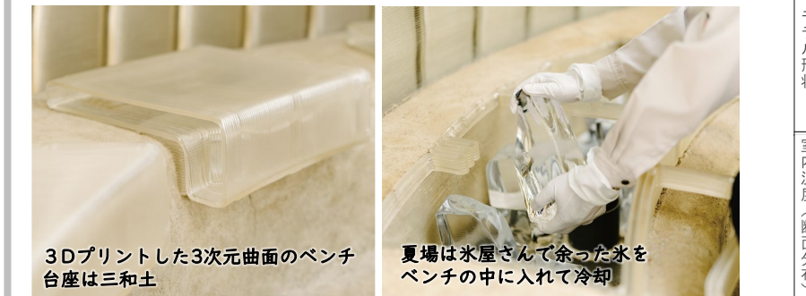
3Dプリントした3次元曲面のベンチ台座は三和土
