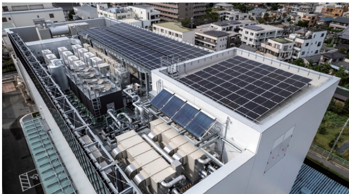
屋上設備機房写真
