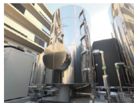
セントラルエコユニットによる自家消費システム 太陽光で発電した電力を有効活用。 この設備で沸かした温水を全住戸に供給します。
