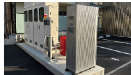
純水素型燃料電池の導入 水素社会を先取りし、SHWの水素燃料電池発電機を設置。 CO2排出ゼロで発電も発電でき、太陽光発電を補います。
