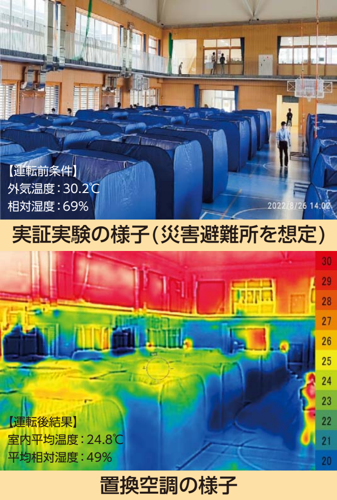
置換空調の様子
