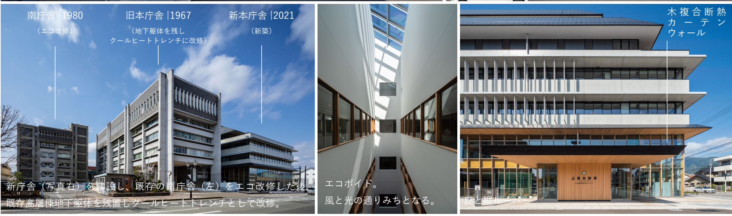
空本庁舎解体後、新本庁舎外観。低層部（市民利用）と中間階（執務）屋根型の上層階（議会）の3層構成。下部旧本庁舎地下躯体利用クールヒートトレンチ
