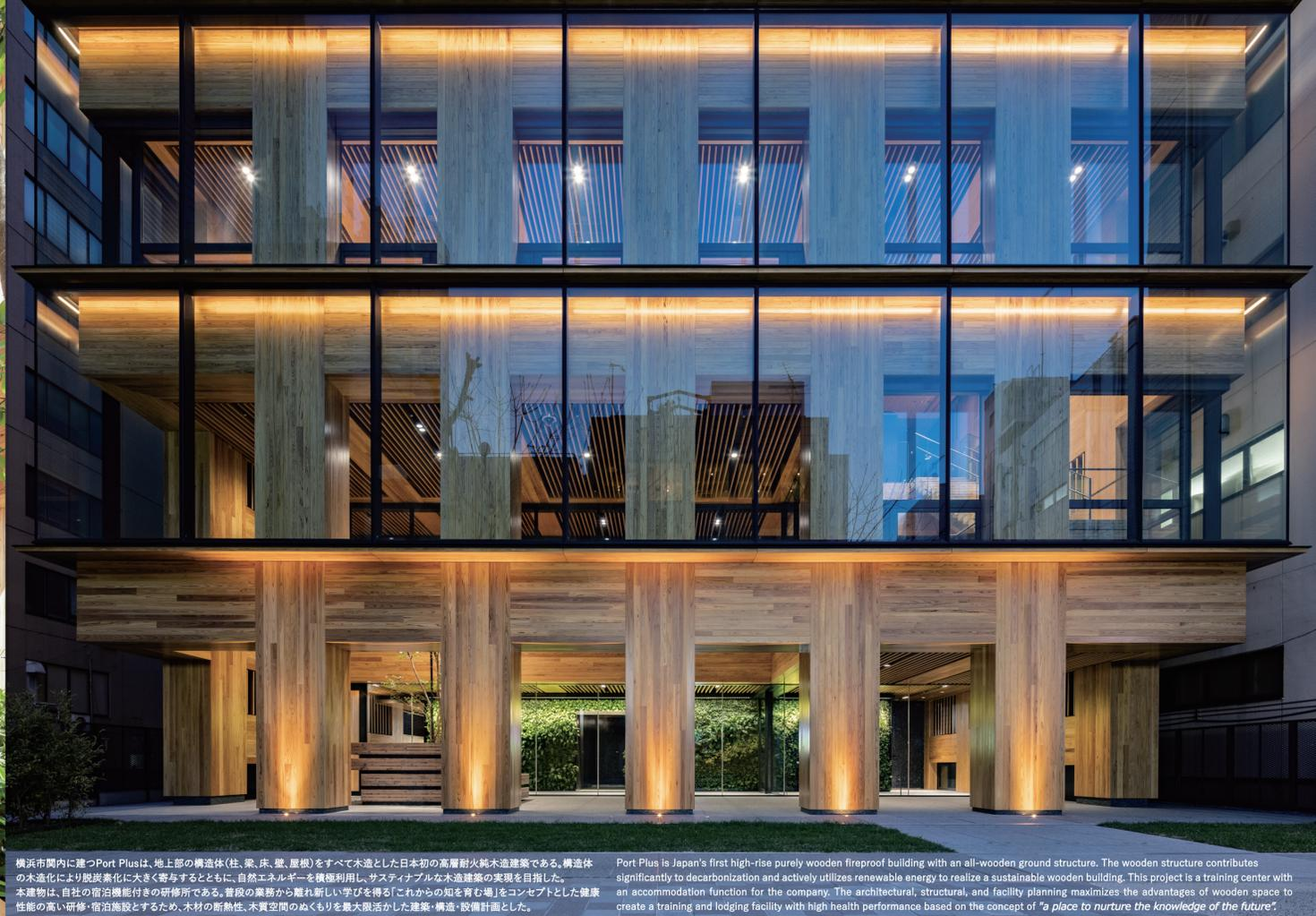
横浜市内に建つPort Plusは、地上部の構造体(柱、梁、床、壁、屋根)をすべて木造とした日本初の高層耐火純木造建築である。構造体の木造化により脱炭素化に大きく寄与するとともに、自然エネルギーを積極利用し、サステナブルな木造建築の実現を目指す。本建物は、自社の宿泊機能付きの研修所である。普段の業務から離れた新しい学びを得る「これからの知を育む場」をコンセプトとした健康性能の高い研修・宿泊施設とするため、木材の断熱性、木質空間のぬくもりを最大限活かした建築・設備計画とした。
