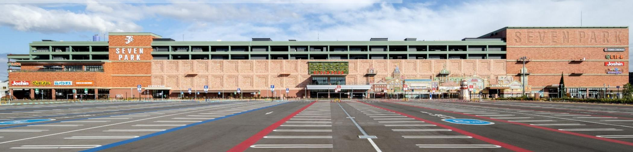
地域環境にインパクトのある大型複合商業施設に、最先端技術を駆使して取り組みました。地域に与える影響を最小限に抑える設備計画を目指し、主要コンセプトを「地球環境保全」と「働きやすさの向上」に設定しました。従来型の普及省エネ技術の採用と共に、天候等から将来予測する先進的な技術を搭載した「次世代BEMS」、同規模商業施設で厨房排水中のごみも対象とした国内初の「バイオガスシステム」にチャレンジすることで、従来商業施設と比較して、**CO2排出量40%削減**を目指しました。敷地内の省エネルギーや省CO2だけでなく、**近隣環境に影響のある廃棄物（生ごみ、污泥）の負荷（運搬・焼却処理）を低減**しています。
