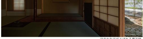
伝統的な茶室では、自然光を取り入れる各種の窓が、茶会や床の間の演出に重要な役割を果たします。通常の茶室では、お茶を点てる主人の手元を明るく照らすため風が先窓を設けています。本計画の様に風呂先窓が外壁に面しない場合は人口照明が設置されますが、光ダクトを用いることで外部と連動して明るさが変わり、より自然に近い採光が可能な計画となりました。光ダクトは、外観を損なわないよう採光面を床下の位置とし、床下2度折り曲げ、風呂先窓面を垂直に立ち上げて意匠性に配慮しました。設計時には光環境シミュレーションを行い、光ダクトの形状検討および有効性の確認を行った上で採用しています。
