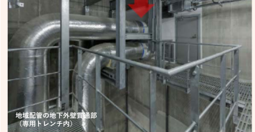
建物内地下駐車場に設置された大型機器搬出入用の防水扉（マンハッチ）
