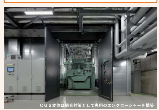
CGS本体は騒音対策として専用のエンクロージャーを構築
