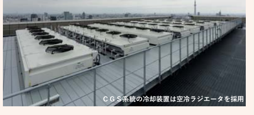
CGSシステムの冷却装置は空冷ラジエータを採用
