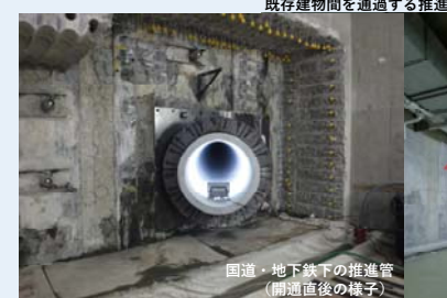
国道・地下鉄下の推進管（開通直後の様子）
