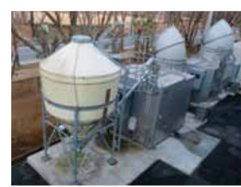
木質ペレット焚吸収冷式温水機
