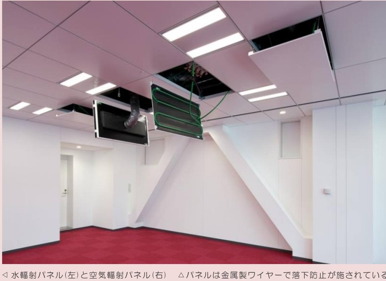
△全て平滑な面で構成された3.6m×3.6mモジュール 空調吹出し等のないすっきりとした表面の天井
