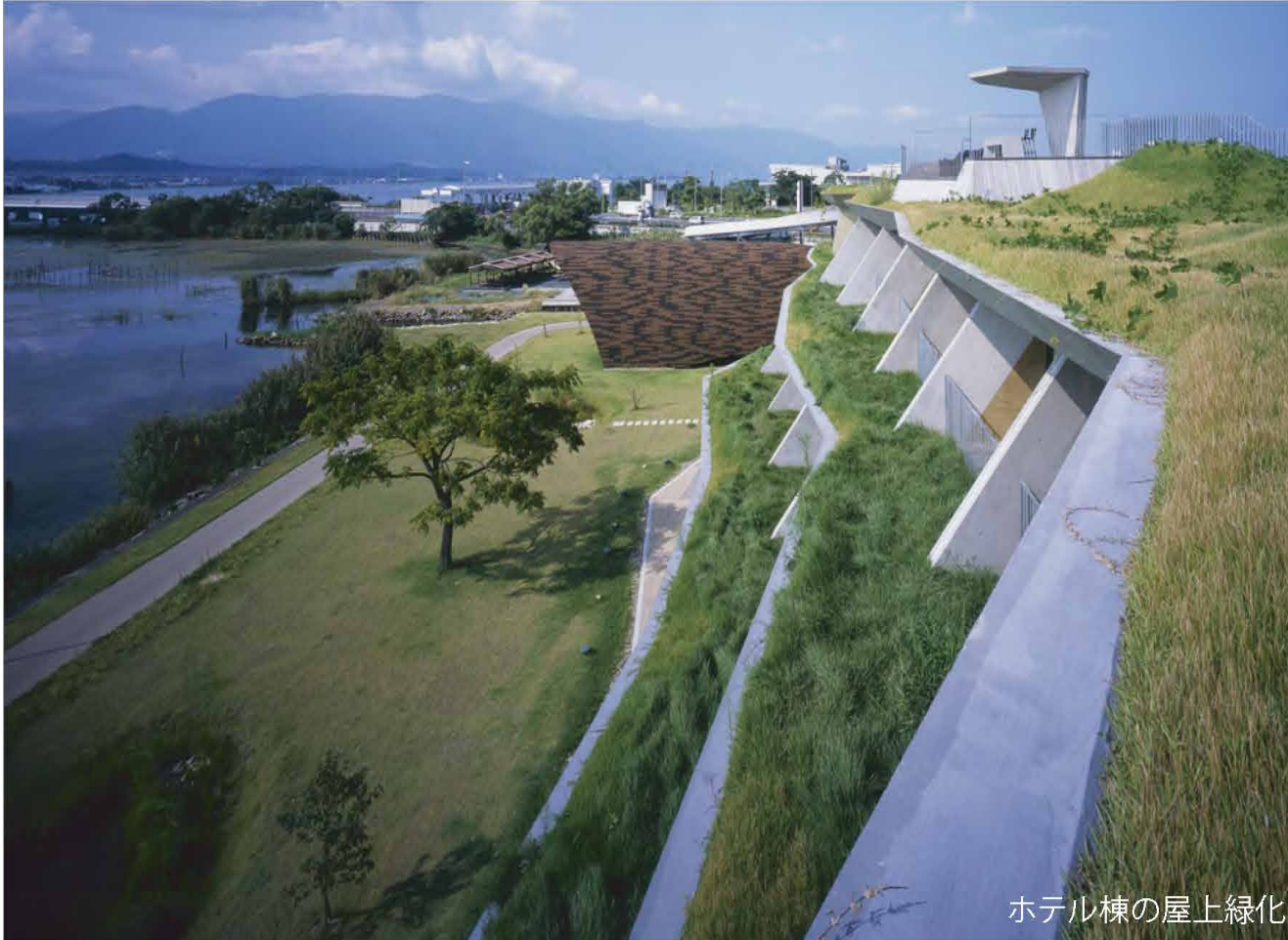
ホテル棟の屋上緑化
