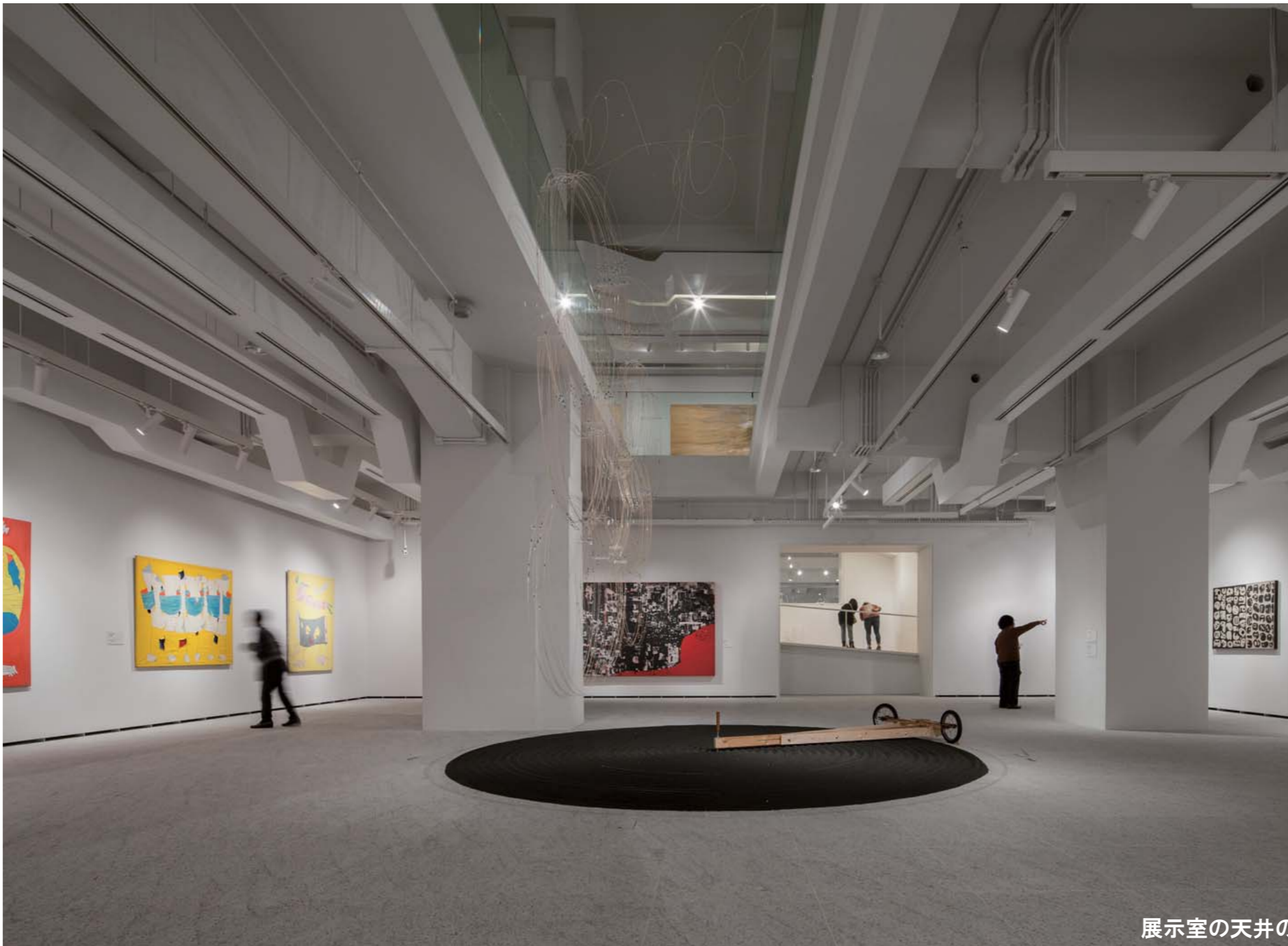
地下1階天井伏施工：展示室の天井は、躯体、空調ダクト、電気ラック等、総合的に検討が重ねられた。
