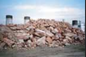
工場の解体で発生した大量の煉瓦塊
