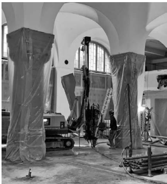
写真－5 ボアホール掘削の工事風景
