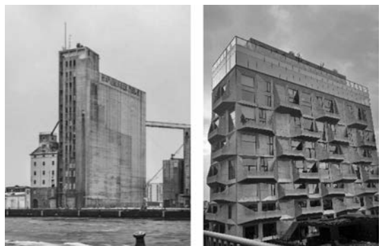
写真ー3 The Silo 改修前
