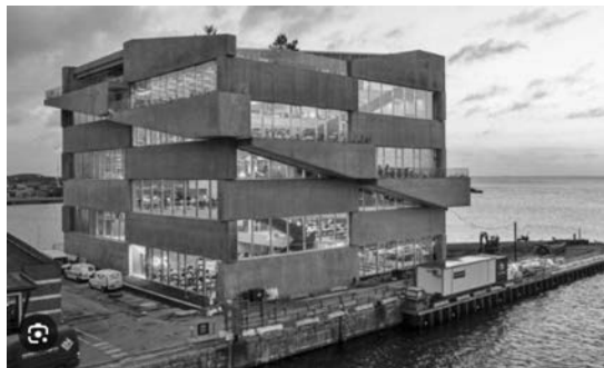
写真－6 BIG 本社の外観
