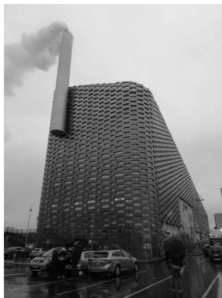
図-4 Amager Bakke 廃棄物発電所
