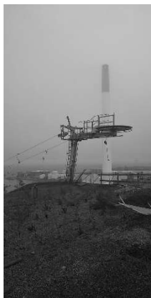
図-6 屋上に設置されたリフト
