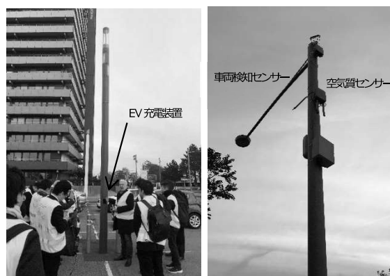
写真-3 インテリジェント照明システム
