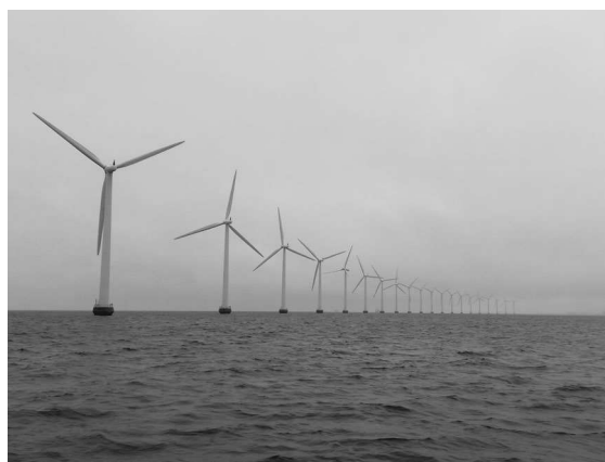
図-1 ミドルグルンデン洋上風力発電所
