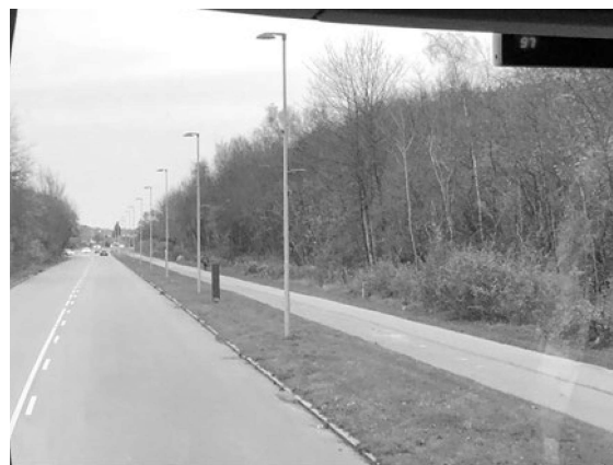
写真-1 占有住宅街区のスマート街灯
